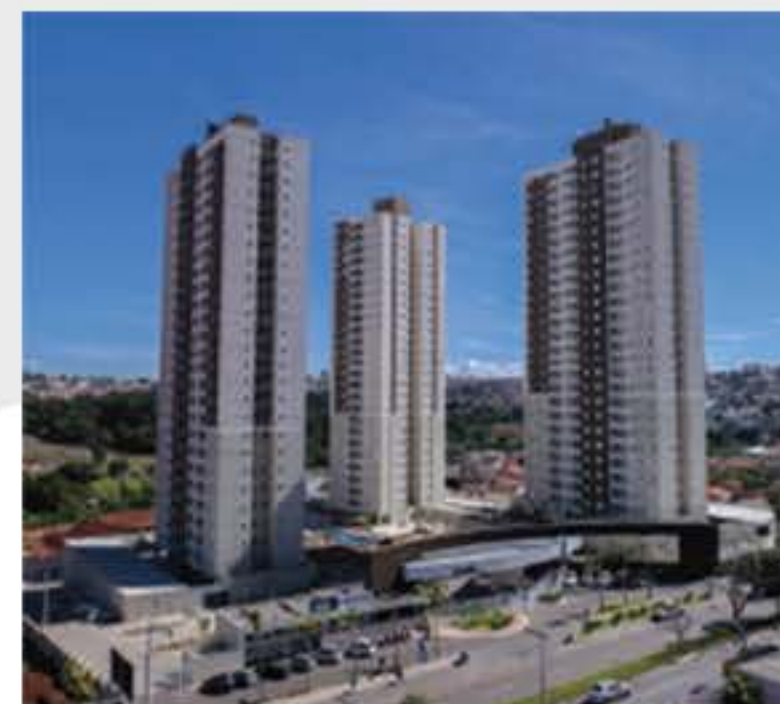
Avenida Parque - 2ª Etapa Anápolis
